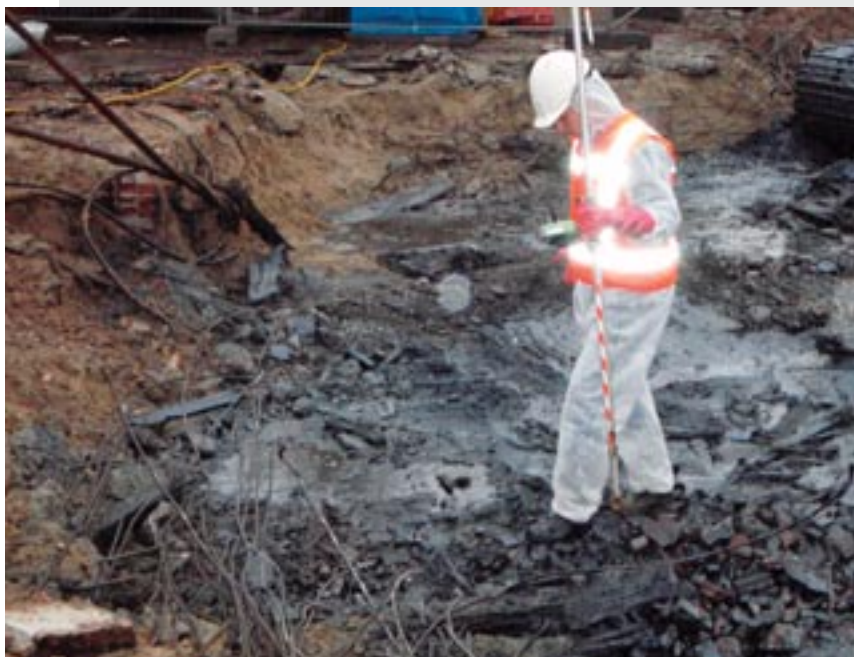
Een archeoloog in veiligheidskleding begeleidt een damwandsleuf. Op de foto zijn resten van de oude gasfabriek zichtbaar.
